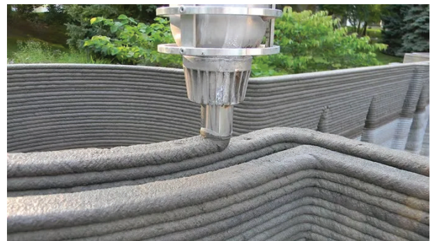
Рис. 1. Будівельний 3D-друк за допомогою бетонної суміші
